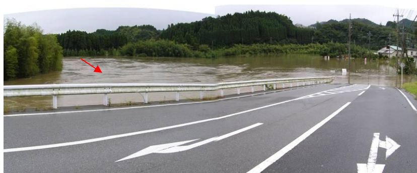
H16. 10. 9 台風22号 による被害状況 （大多喜町西部田）
