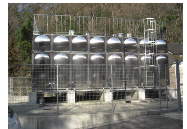
栗柄高区配水池 (平成17年度完成)
