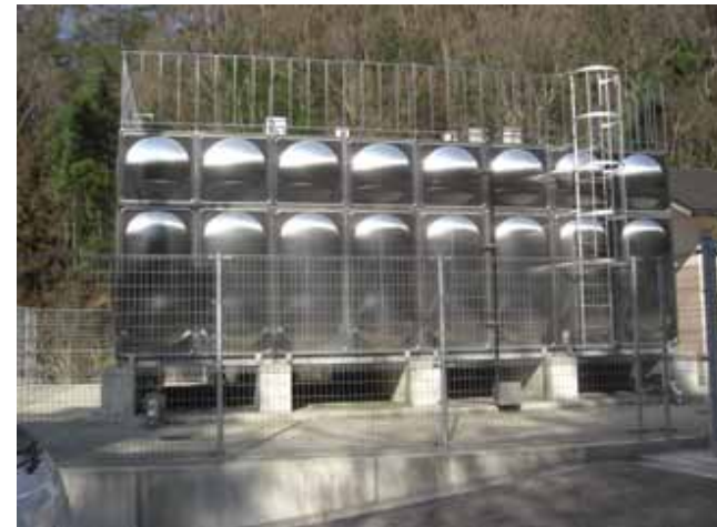
栗柄高区配水池(平成17年度完成))
