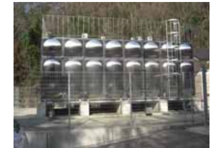
栗柄高区配水池(平成 17 年度完成))
