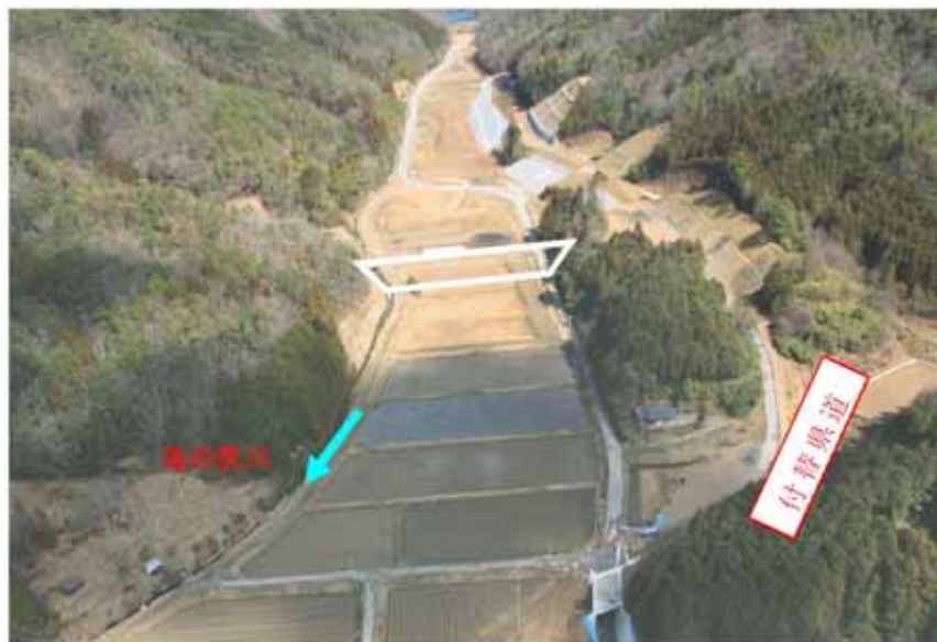
ダム下流からダムサイトを望む (平成 21 年 3 月撮影)
