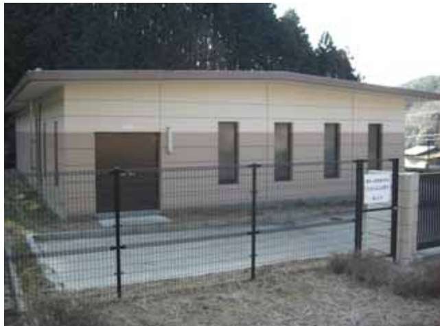
栗柄低区配水池(平成16年度完成)
