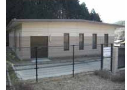
栗柄低区配水池(平成 16 年度完成)
