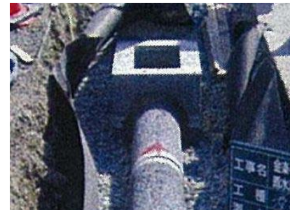
写真 2.2.11 浸透側溝
