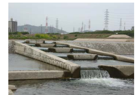
写真 2.2.20 床止めに設置された魚道
