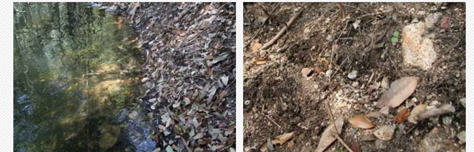
写真. 汀線付近の侵食状況
