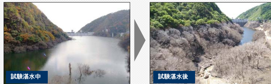
図、石井ダムにおける試験湛水の実施状況
