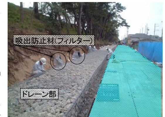
写真 2.2.4 堤防強化工事の例(ドレーン工)
