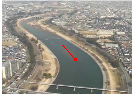
写真 2.2.1 下流部築堤区間
