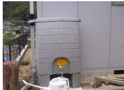
写真 2.2.10 雨水貯留タンク
