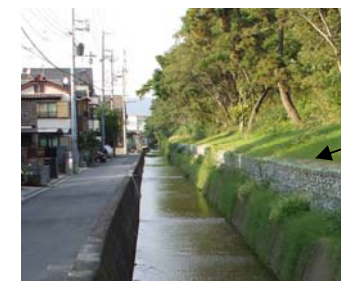
写真 4.1.1.1 ドレーン工法 の施工例
