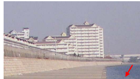
写真 2.2.5 高潮対策事業で整備した防潮堤
