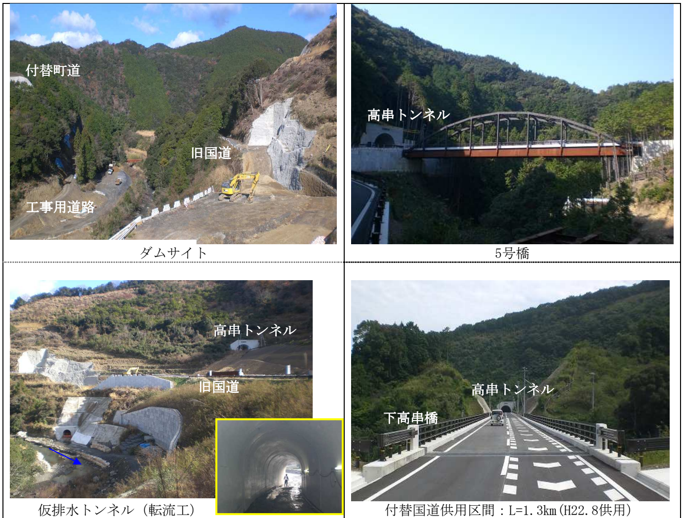
図-3.3.2 切目川ダム進捗状況写真
