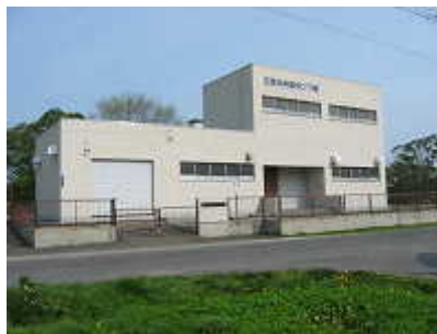
図 6.4.6 ポンプ施設 (江別太中継ポンプ場※)
