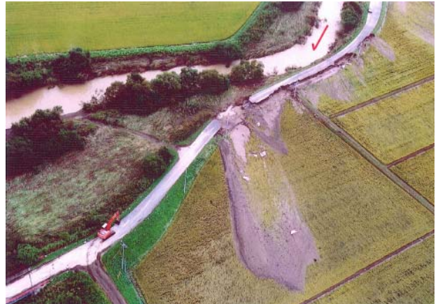
被災写真 (檜山橋付近)
