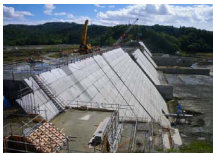
当別ダム(建設中)
