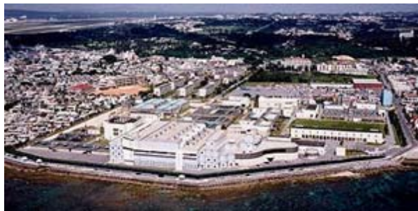
図 6.4.9 北谷浄水場（沖縄県）
