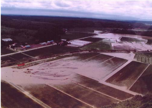
被災写真 (宇隆橋付近)
