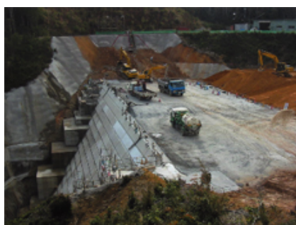
大保ダム沢処理工
