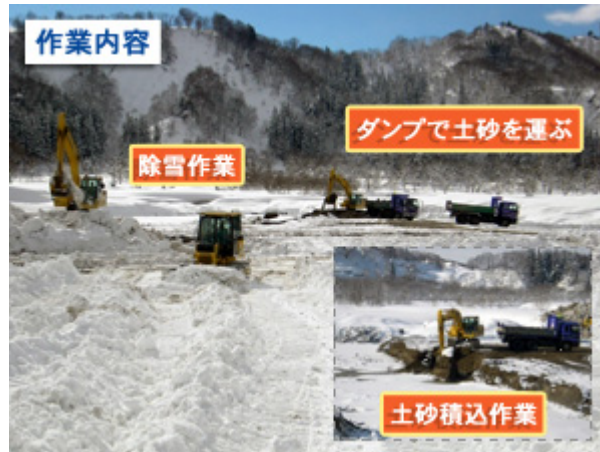
図 6.4.7 白川ダムの貯水池掘削の様子（山形県）
