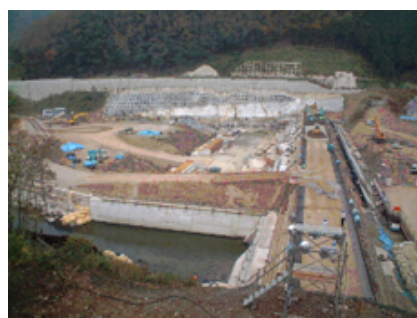
灰塚ダム川井堰堤
