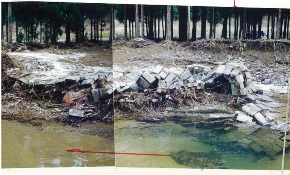
写真-④ 平成 10 年 9 月 上流護岸被災状況
