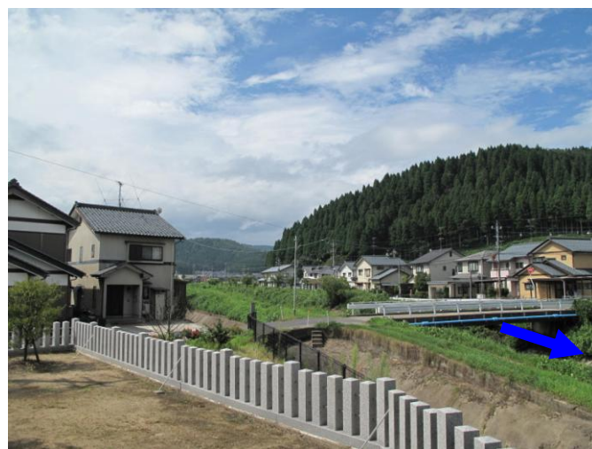
写真-1 吉野瀬川上流部の状況
