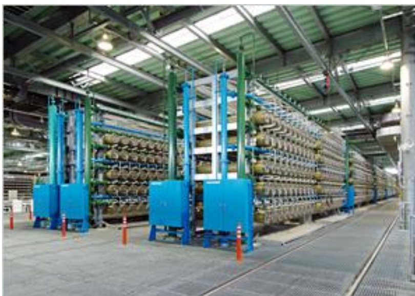
高圧 RO 膜設備
