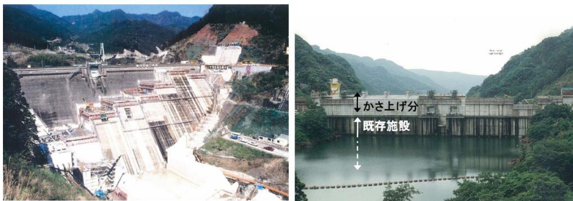
ダムかさ上げ
