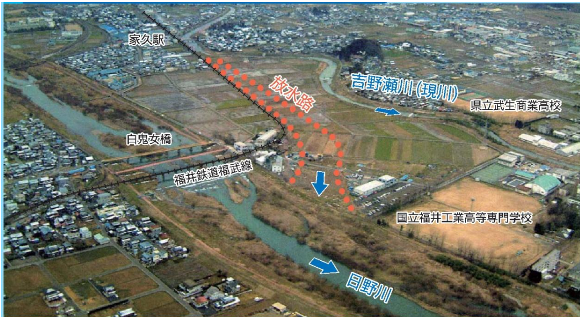
図- 2.18 放水路区間
