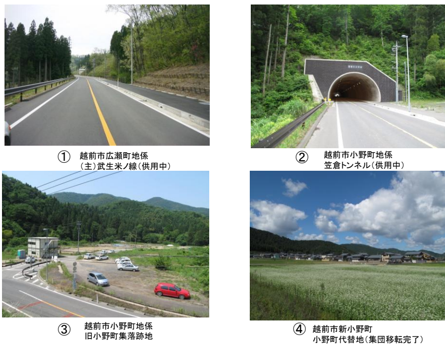
図- 3.10 進捗状況写真
