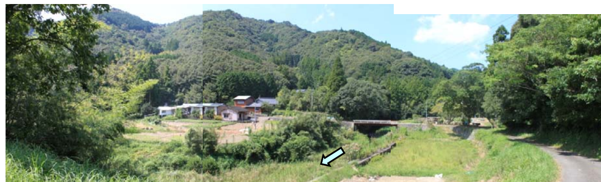
写真-1.2 中流部藤ノ川地区の状況
