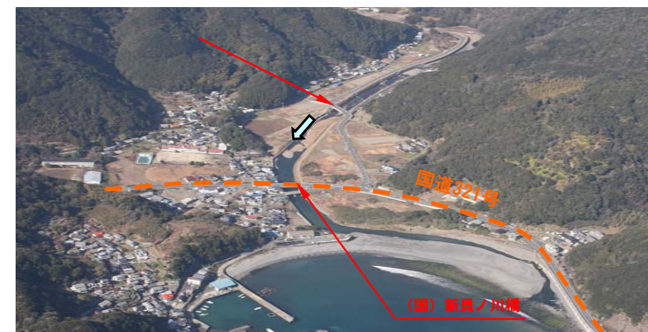
写真-1.3 下流部貝ノ川地区の状況
