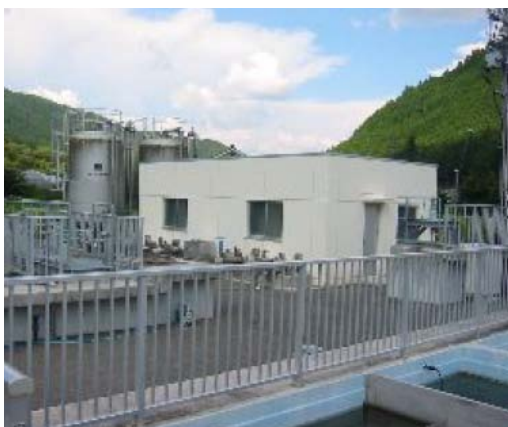
哲西簡易水道第3水源・浄水場
