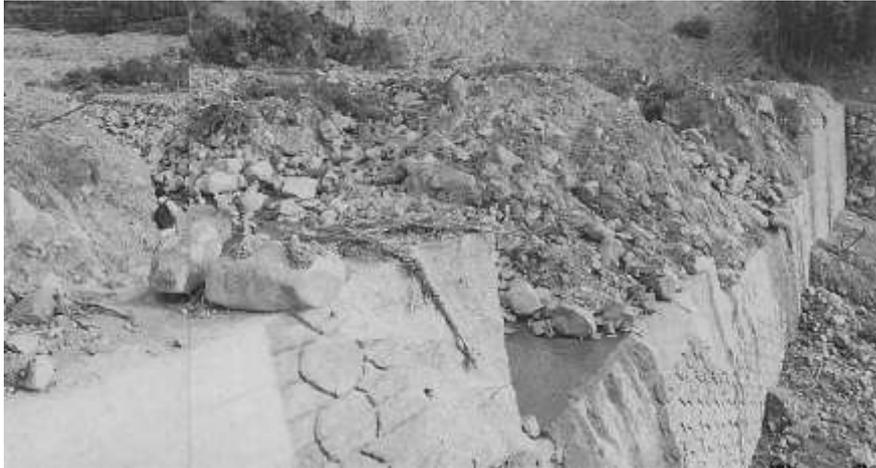
写真一20 針原川砂防堰堤の被災状況
