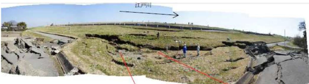
写真－6 東北地方太平洋沖地震による利根川水系江戸川の堤防の被災状況
