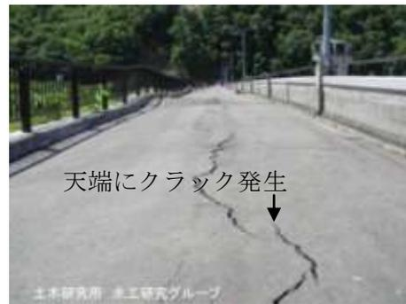
写真-11 石淵ダムの被災状況
