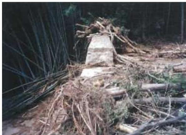
写真一21 砂防堰堤の被災状況
