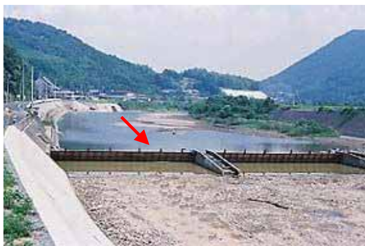
図 2.2.5 山道堰の渇水状況(平成 6 年 9 月)
