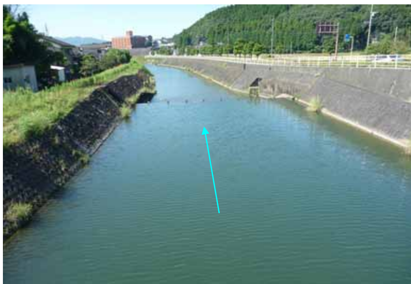
図 2.3.6 石木川合流点上流の改修状況(横枕橋下流)
