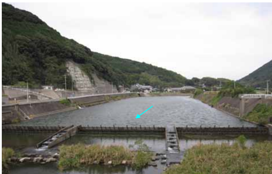
図 2.3.5 石木川合流点下流の改修状況(山道堰付近)
