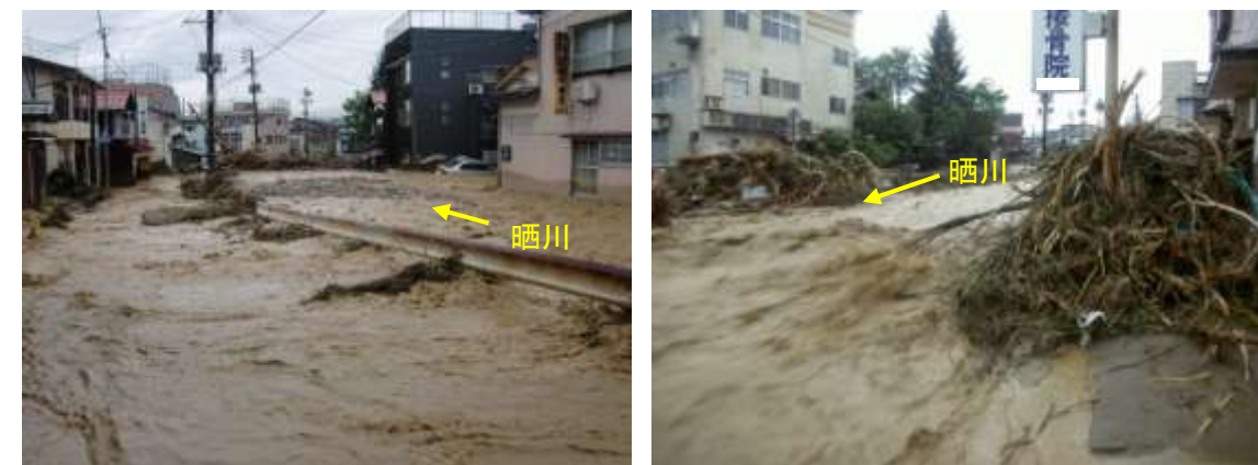
写真 1.1 晒川 H23.7.30 出水状況(田川合流点より 0.2km 付近)
