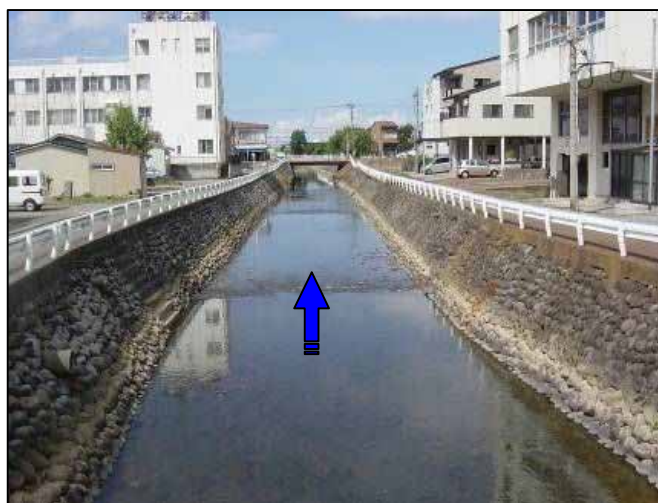
図 2.1.6 儀明川沿いの土地利用状況（六ノ辻橋（2K 付近））
