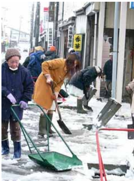
図 2.4.3 流雪溝を利用した除雪作業
