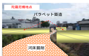
堤防整備、河床掘削
