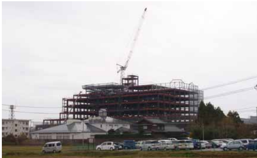
図 4.1.12 建設中の佐渡総合病院
