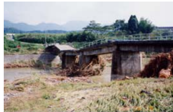
写真 1.3 平成5年9月洪水 被災した平野橋
