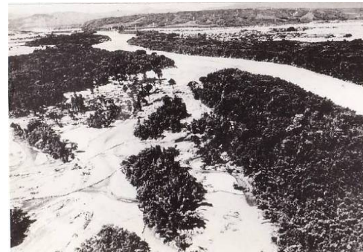
あかがわ かわしま 旧安曇川町川島地先の堤防決壊状況
