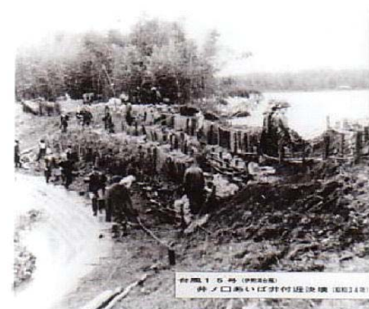
しんあさひ いのくち 旧新旭町井ノ口地先あいば井付近の堤防補強状況
