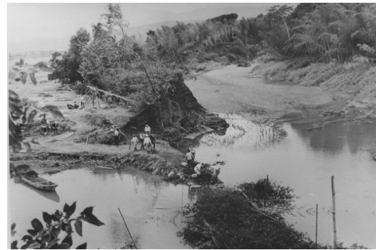
あかがわ ふたつや 旧安曇川町二ツ矢地先の堤防決壊状況
