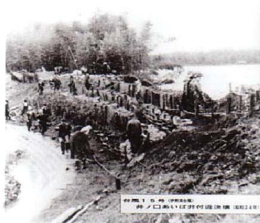
しんあさひ いのくち 旧新旭町井ノ口地先あいば井付近の堤防補強状況
