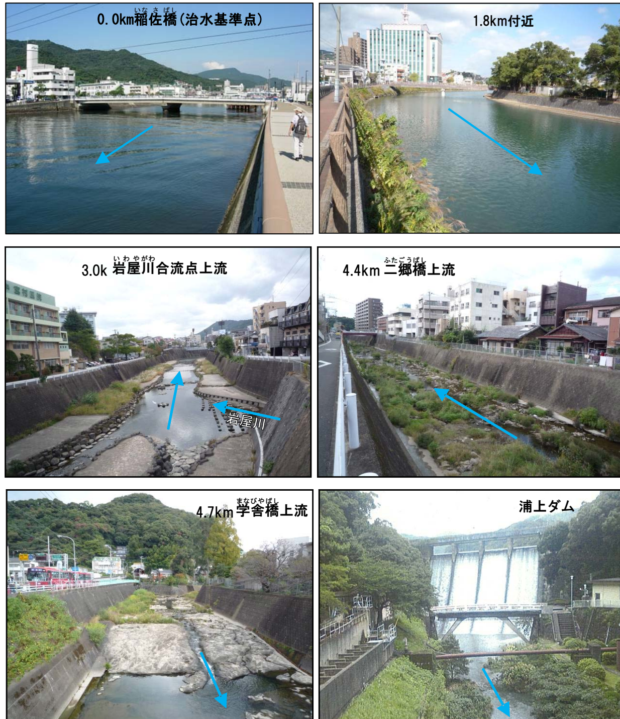
写真 1.1 浦上川及び浦上ダム現地状況
