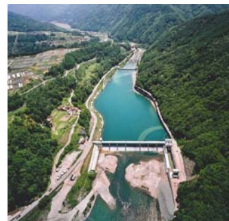
分派堰・土砂バイパストンネル
