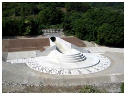
土砂バイパストンネル吐口
