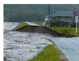
H18.7 災害 堤防決壊 (箕輪町松島地区)
