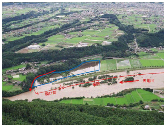
図 4.47 平成 18 年 7 月洪水時の状況
