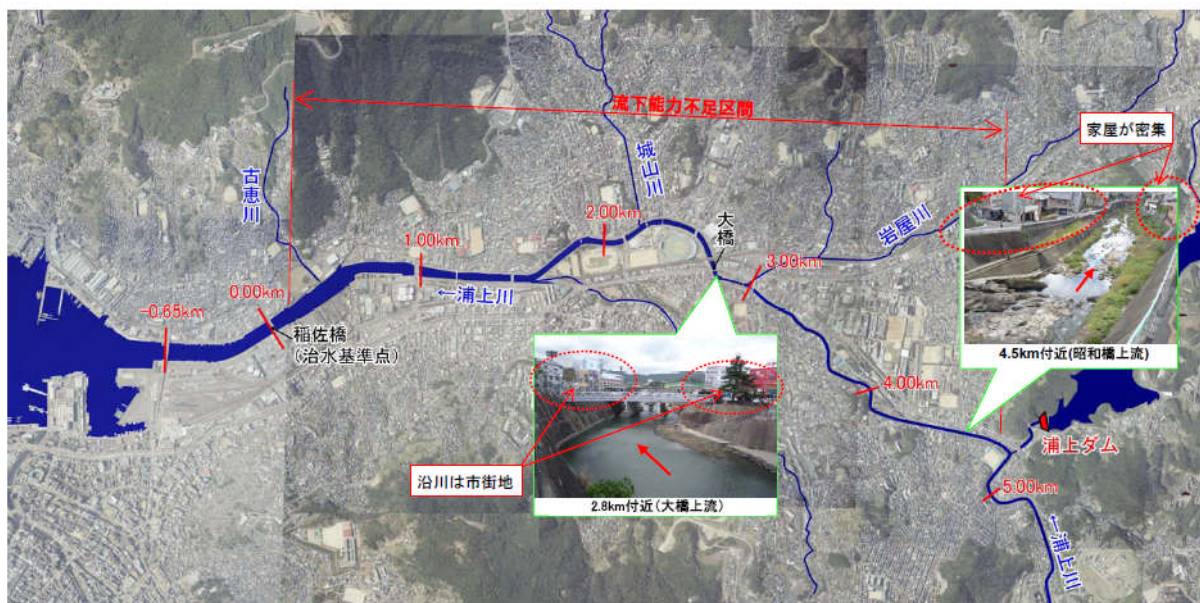
図 4.54 浦上川沿川の状況
