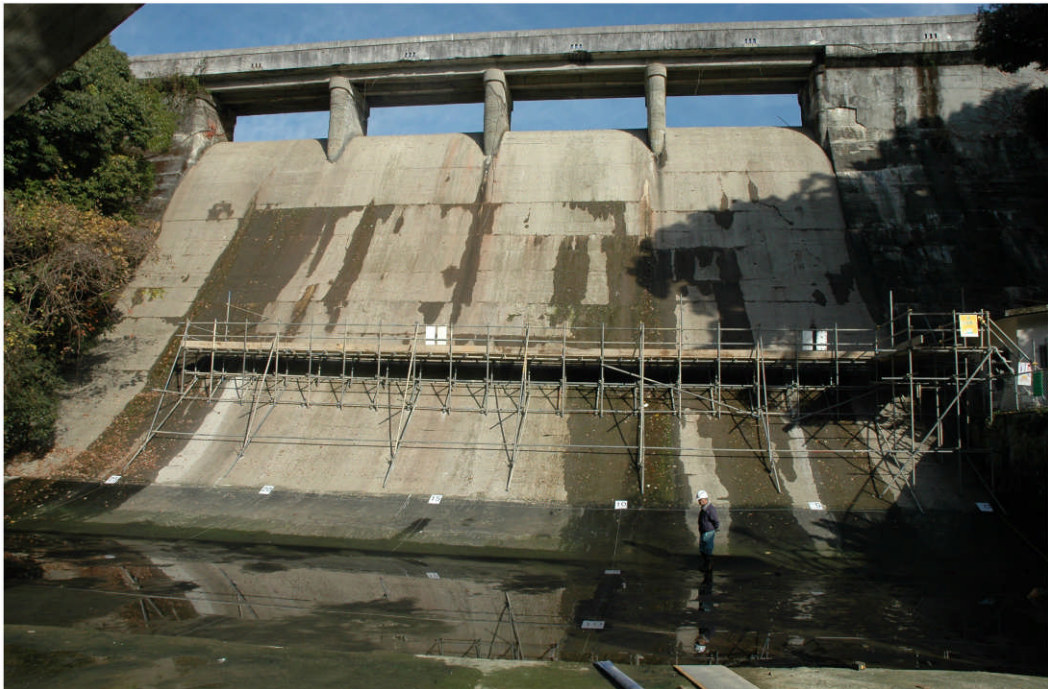
図 4.92 下流面からの漏水状況
