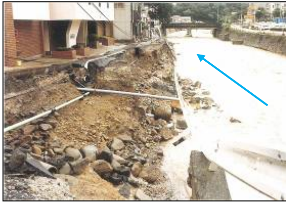
浦上橋上流(扇町)
