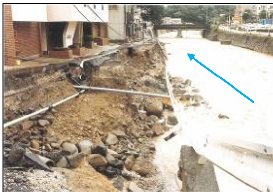
浦上橋上流（扇町）
