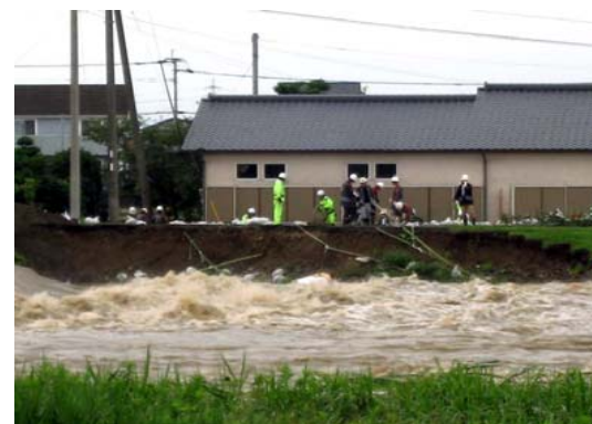
写真 1-3 H24. 7. 14 洪水 堤防の崩れに対する水防活動 (竹流し・土のう積み)
