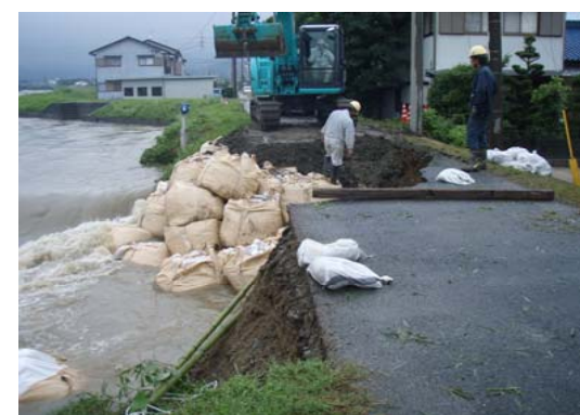
写真 1-4 H24. 7. 14 洪水 堤防の崩れに対する大型土のう による応急対策状況
