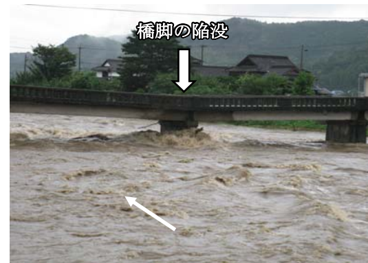
写真 1-2 H22. 7. 14 洪水 洪水により被害を受けた橋梁
