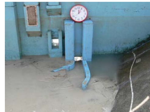
写真-②融雪期放流ゲートを開いた状態 (土砂排出を確認)
