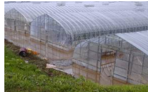
写真 1-2 平成 15 年 8 月洪水 (沙流川 日高町荷菜地区の冠水被害状況)
