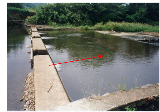
平成6年の渇水状況 (殿敷堰)
