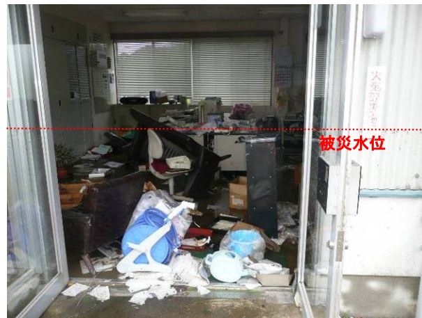
平成22年7月洪水災害の状況 (豊田町手洗地区 石町観測所付近)
