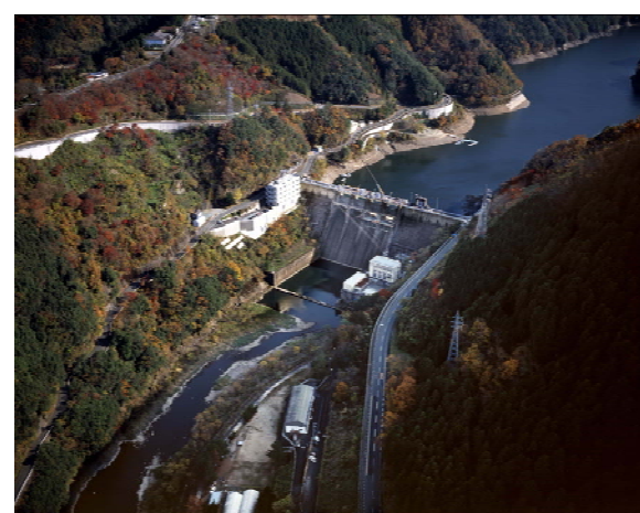
写真 1-9 鹿野川ダム（肱川発電所）
