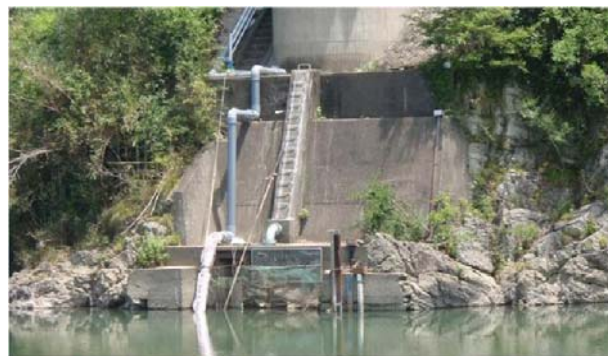
写真 1-8 渇水による水位低下時の取水塔の状況 (平成 21 年)
