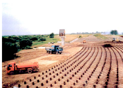
パイルネット工法
