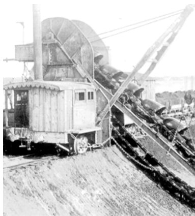
大正期の新水路掘削作業
