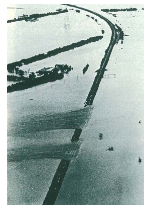
下新篠津築堤の破堤状況
