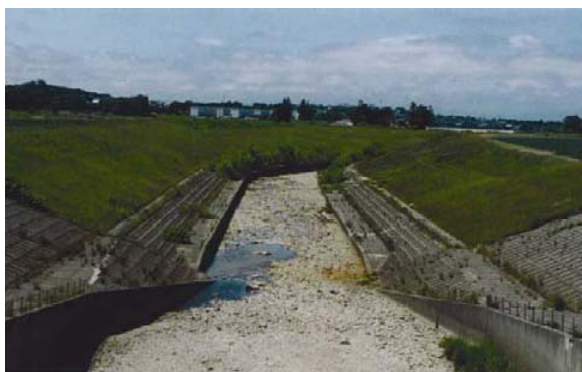
三笠市岡山地先における湧水時の状況
