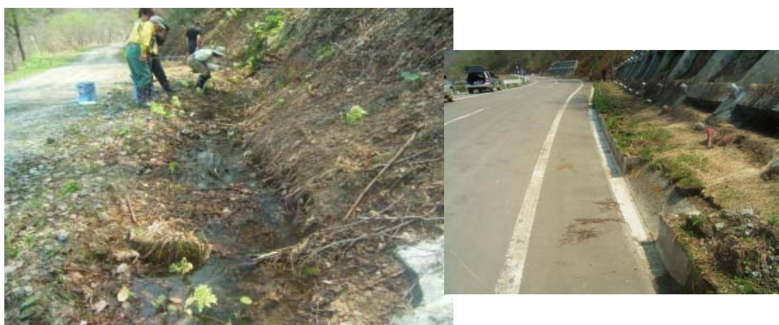
図 3.2-1 動物の移動に配慮した側溝の設置例
