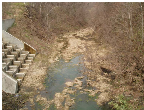
桂沢ダム下流における湧水時の状況
