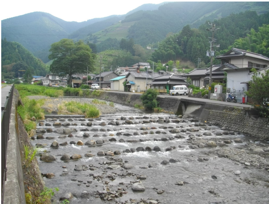
写真 5.1 床固めの一例（0.8k 下田橋上流付近）
