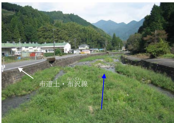
0.9k 付近から下流を望む 掘込河道であり河川沿いに市道が整備され家屋が立地
