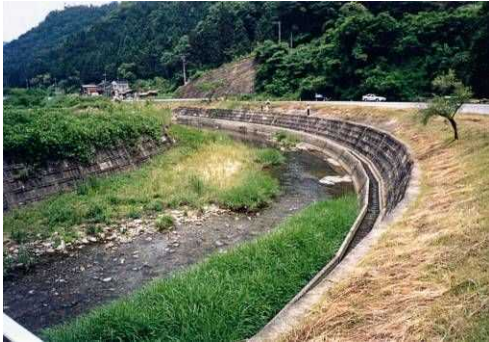
写真 2.1.4 ①矢板橋下流
