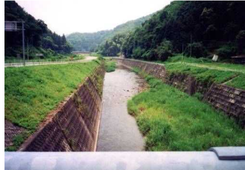
写真 2.1.5 ②出合橋より上流
