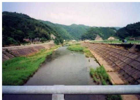
写真 2.1.9 ⑥用田橋より上流
