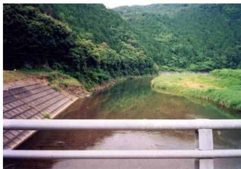
写真 2.1.8 ⑤西方寺橋より上流
