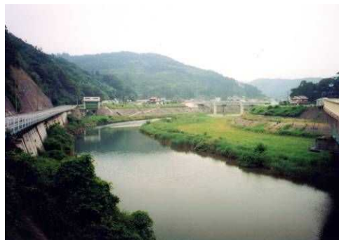
写真 2.1.11 ⑧三隅大橋より上流
