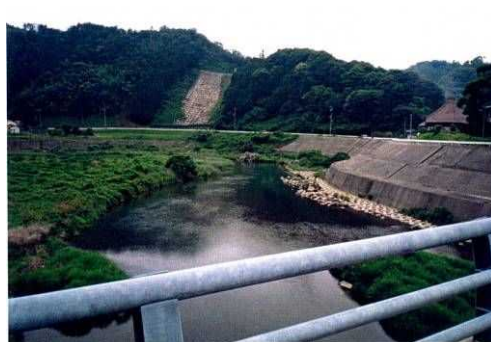
写真 2.1.10 ⑦杉の森橋より上流
