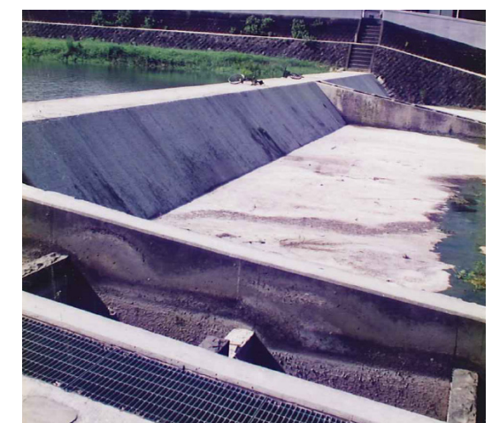
写真 1-6 平成 6 年 公園堰
