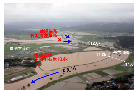
子吉川、石沢川堤防の決壊及び氾濫状況（11.0k 付近）
