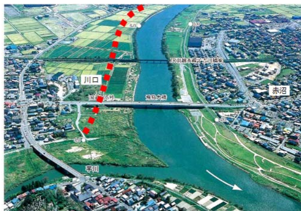
図 2.4-5 川口地区 堤防整備箇所
