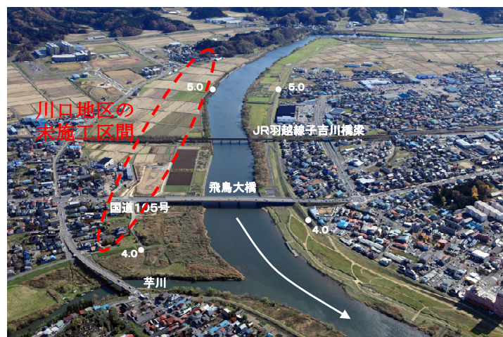
図 4.2-22 未施工区間の例 (川口地区)
