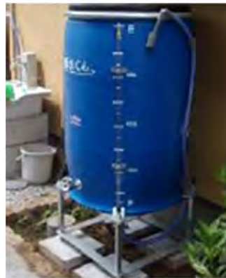
図 4.3-58 家庭用の雨水貯留タンク
