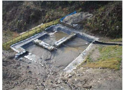
写真 3.2-4 沈砂池の設置状況
