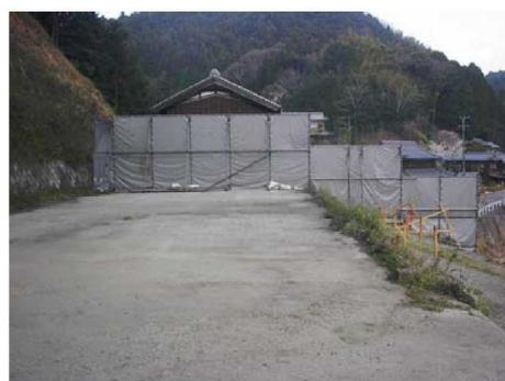
写真 3.2-2 防音壁の設置状況
