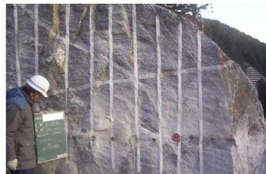
写真 3.2-9 騒音の低減(静的破碎工法)
