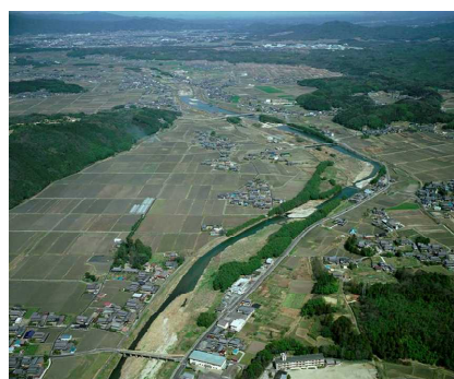
木津川（三重県管理区間）67～69k 付近
