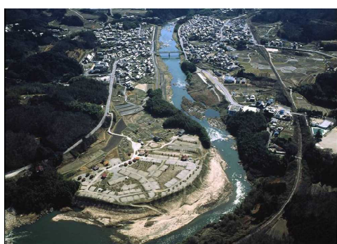
木津川上流（大臣管理区間）51～52k 付近
