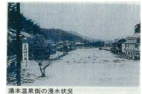
湯本温泉街の浸水状況 昭和29年9月25日 洞爺丸台風による出水状況
