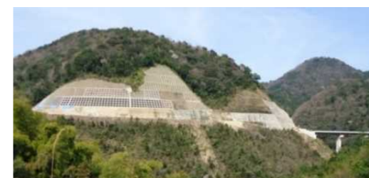
【県道付替工事】
