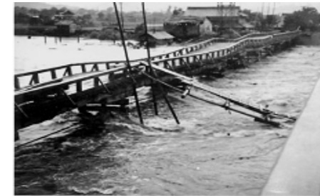
緑橋流出状況 昭和26年10月13日 ルース台風洪水による出水状況
