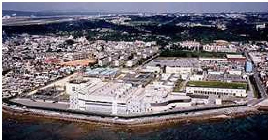
出典：沖縄県企業局HP， 沖縄県海水淡水化施設
