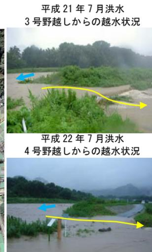
※城原川の上流部には歴史的な治水施設である野越しといわれる堤防の一部が低い箇所が存在し、現在もJR長崎本線より上流に 9 箇所残っている。野越しにはあふれた水の勢いを弱め、広がっていかないよう水害防備林や受堤が設けられていたが、受堤等の一部が撤去されたことから、野越しからあふれる洪水による周辺家屋への浸水被害が懸念される。
