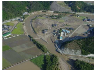
H16. 10.18~22 台風23号による 東かがわ市の被害状況
