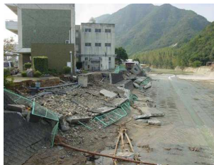
H16. 10.18~22 台風23号による 東かがわ市（福楽小学校）の被害状況
