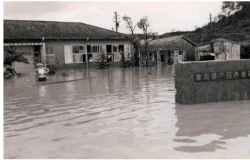
S49. 7.1~12 台風8号による 東かがわ市（旧白鳥町）の被害状況
