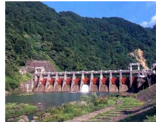
図 1.6 庄川用水合口ダム
