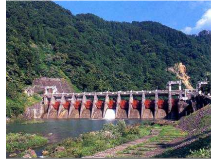
図 2.2.9 庄川用水合口ダム
