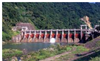
庄川用水合口ダム
