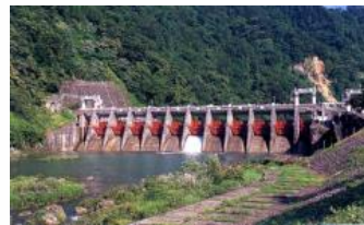
庄川用水合口ダム
