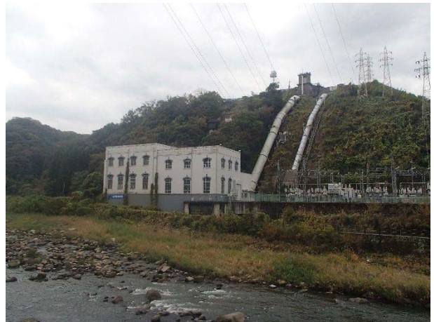
写真 2.2-5 女子畑発電所（日田市天瀬町）
