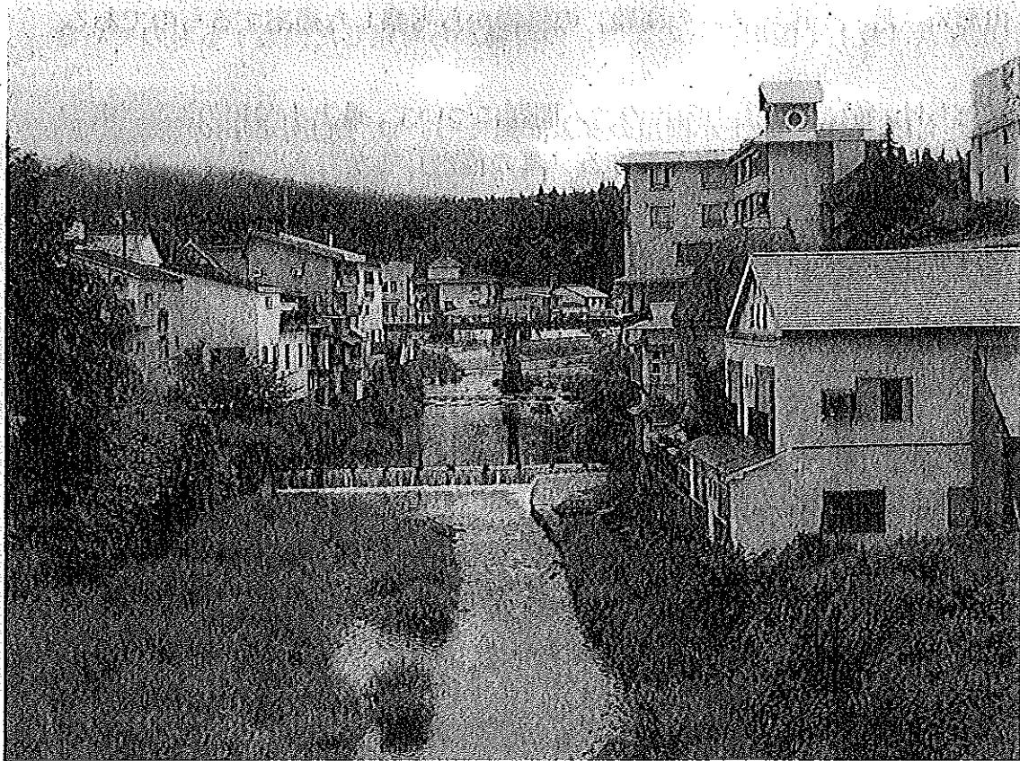
赤倉温泉地域、下流から上流をみたもの。手前にある「固定堰」が多くの土砂堆積の原因となっている。
