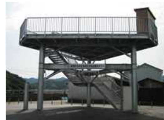
津波避難タワー
