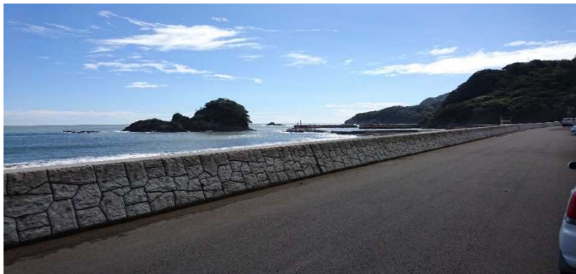
日和佐港L1防潮堤改良事業
