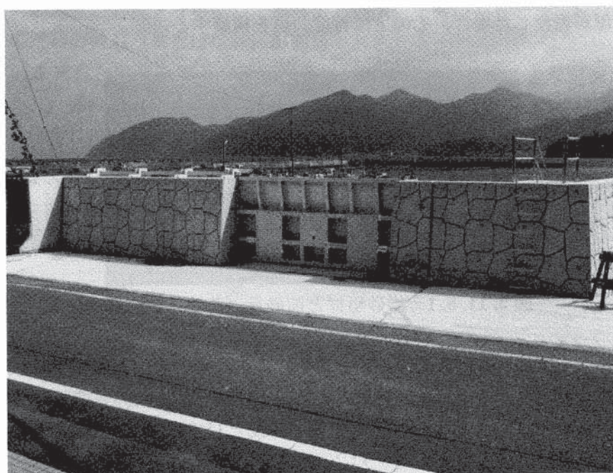
写真 3.11.4.1 陸閘の写真：静岡県八木沢漁港海岸
