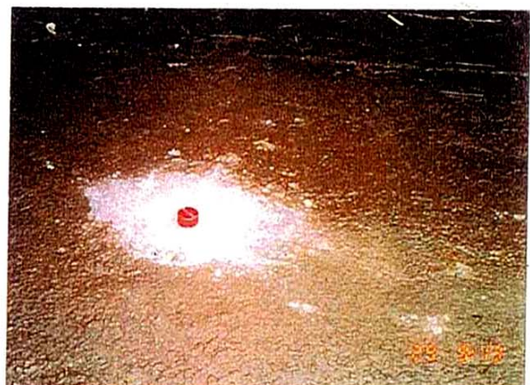
写真-22 設置後の状況
