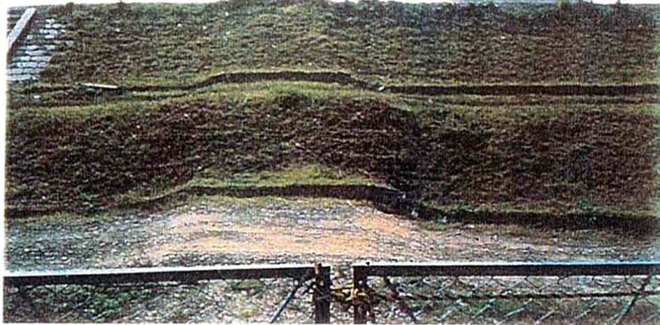
写真-1 樋管付近の盛土の抜け上がり（最大 35cm） ブロック付近の盛土には空洞が生じている。
