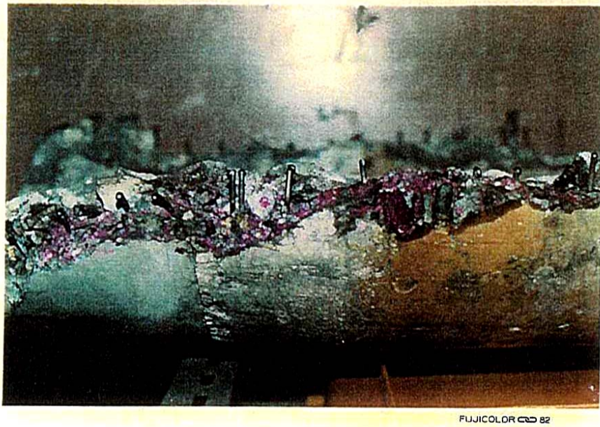
写真-10 コンクリートの破断面のフェノールフタレイン処理による発色. 新鮮でアルカリ性の部分が桃色～紫色になり 風化して中性化した部分は発色しない.
