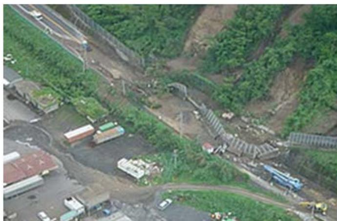
法面崩壊・擁壁倒壊が発生した国道 220（垂水市牛根麓）
