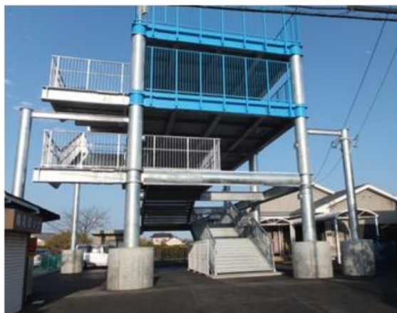
津波避難タワーの導入例
