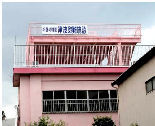
津波避難ビル（既存ビルの屋上に増築）
